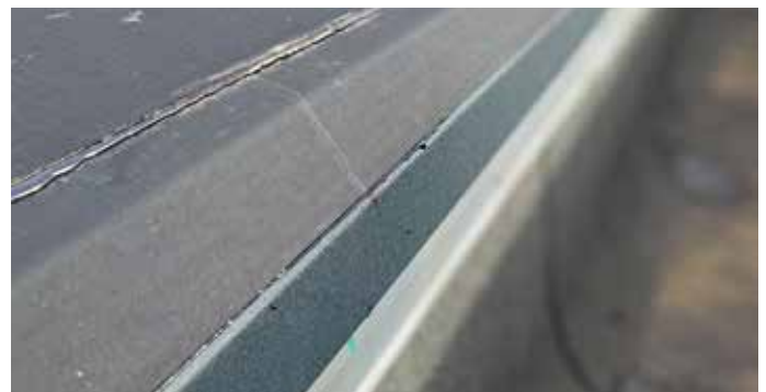
Die bis zu 3,1 mm dicken EPDM Bahnen können durch das unterseitige Polymerbitumen mit Heißluft verschweißt werden, auch auf Holz und Bleche. Die gleichmäßig austretende Bitumenraupe ermöglicht eine optische Kontrolle.
