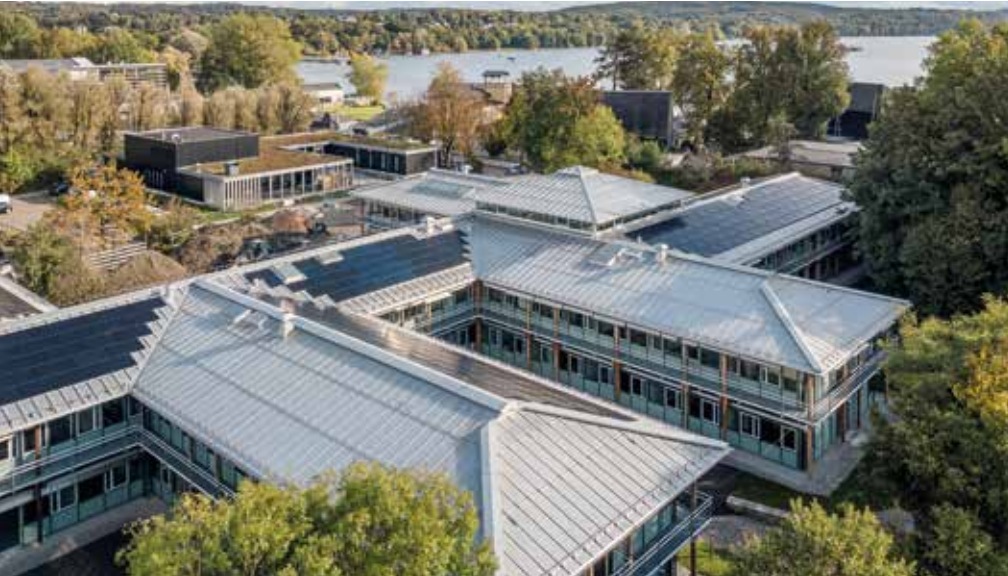
Modulbefestigung auf Uginox Patina K41 mit Stockschraube in Leistentechnik. Landratsamt Starnberg | Auer Weber Architekten BDA – ausgezeichnet mit dem DAM Preis 2023 des Deutschen Architekturmuseums. | Foto: © Aldo Amoretti
