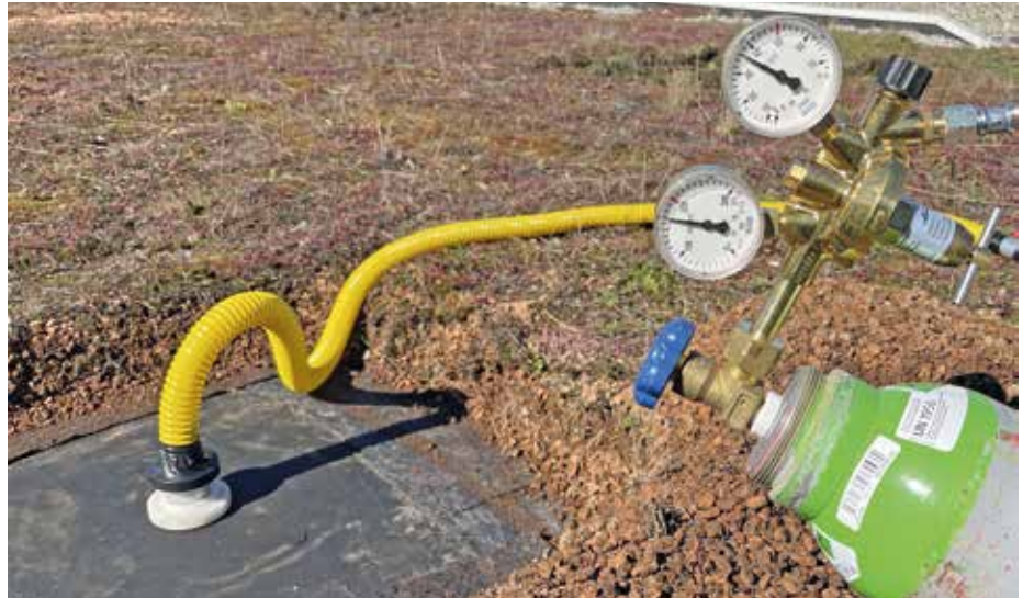
Tracer- oder Spürgasverfahren bei einem extensiv begrünten Dach.
