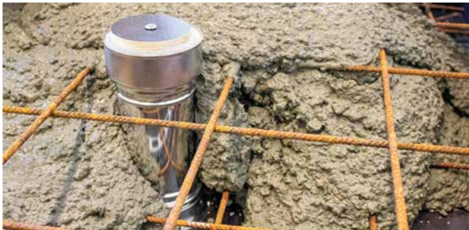
Direkt mit eingegossen: So erspart SitaConcrete Montageaufwand, Kernbohrungen, Anschlussprobleme und Dichtigkeitslücken.
