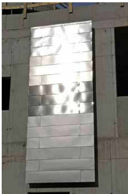
ROOFINOX (untere 6 Reihen) ist 4-mal matter als herkömmlicher Edelstahl.
