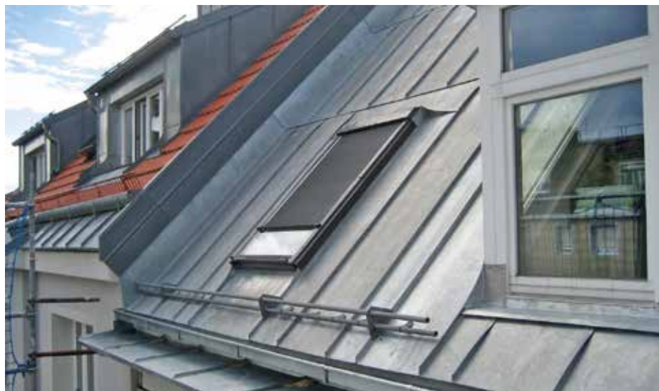
Bild links: Massive Wellenbildung aufgrund durchlaufender Schare und fehlender Quernahtausbildung.
