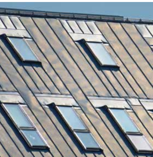
Bild links: Massive Wellenbildung aufgrund durchlaufender Schare und fehlender Quernahtausbildung.
