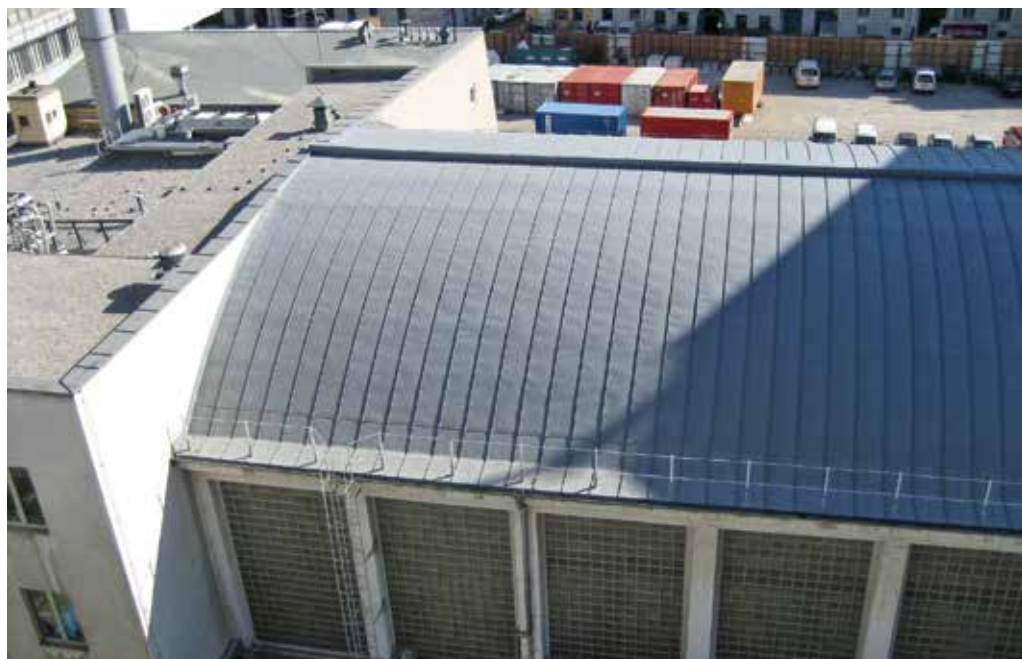
Tonnendach mit traufenseitigem Dachknick und durchlaufender Quernaht.
