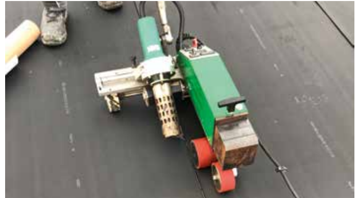
Die bis zu 3,1 mm dicken EPDM Bahnen können durch das unterseitige Polymerbitumen mit Heißluft verschweißt werden, auch auf Holz und Bleche. Die gleichmäßig austretende Bitumenraupe ermöglicht eine optische Kontrolle.
