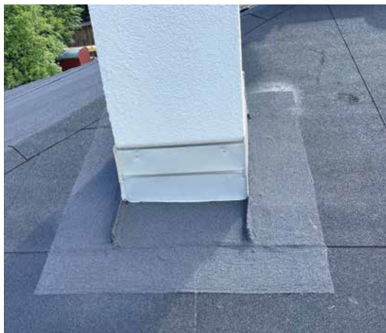
Die Abdichtung wurde im Farbton RAL 9005 ausgeführt, außerdem wurde Schiefersplitt in das noch feuchte Material eingestreut. Auf diese Weise fügen sich die sanierten Bereiche harmonisch ins Gesamtbild ein.
