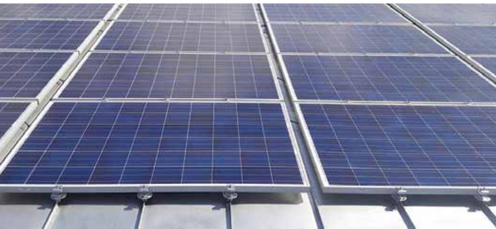
Befestigung von Modulen mittels Falzklemme und PV-Kit. Bei dieser Befestigungsvariante sind keine Modulträgerprofile erforderlich. | Foto: © S-5! - Roof-Tech GmbH
