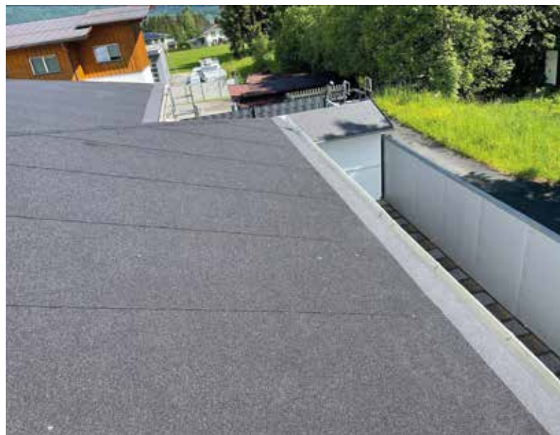
Die Abdichtung wurde im Farbton RAL 9005 ausgeführt, außerdem wurde Schiefersplitt in das noch feuchte Material eingestreut. Auf diese Weise fügen sich die sanierten Bereiche harmonisch ins Gesamtbild ein.
