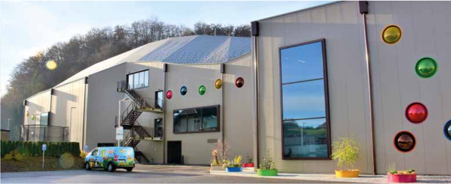
Das ansprechende Gebäude mit der Fassade, den farbigen Bullenaugen und mit den Dachwasserabläufen.
