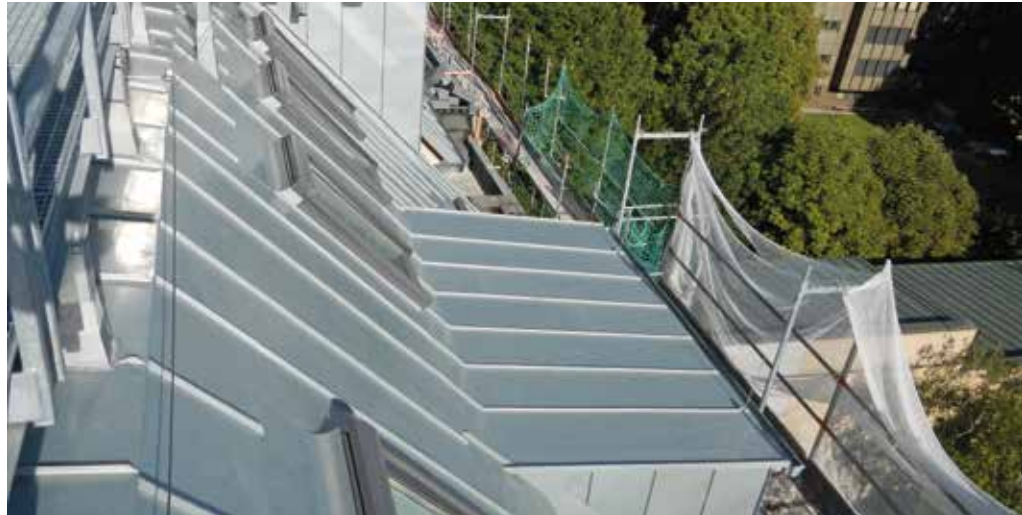
Fachgerechte Trennung mittels durchgehender Quernahtausbildung.
