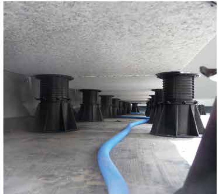
VersiJack K Stelzlager mit nachträglicher Feinjustierung
