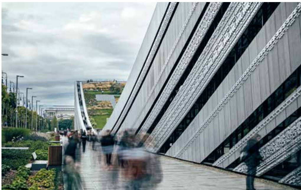
Über 2.000 Metallraster umgeben das Museum bis hinauf zur Traufkante. Auf den Gitterrastern wurden insgesamt eine halbe Million kleiner Würfelemente eingearbeitet.
