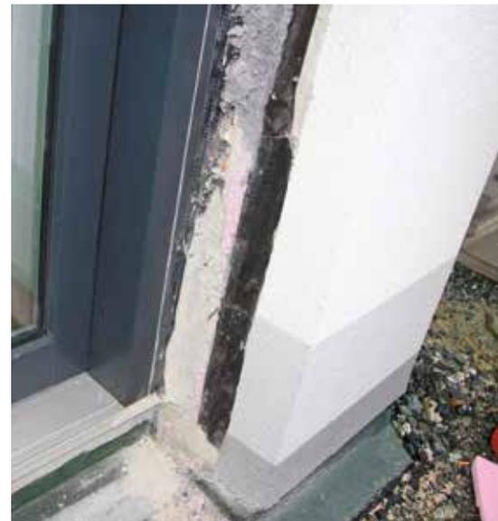
*Beispiel eines misslungenen, seitlichen Abdichtungsanschlusses an ein Fenster. Die Führungsschienen des Fensterzubehörs sind demontiert. Die Laibung einsehbar.*
