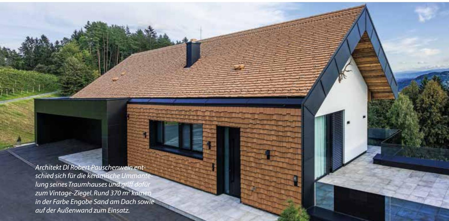
Architekt DI Robert Pauschenwein entschied sich für die keramische Ummantelung seines Traumhauses und griff dafür zum Vintage-Ziegel. Rund 370 m<sup>2</sup> kamen in der Farbe Engobe Sand am Dach sowie auf der Außenwand zum Einsatz.
