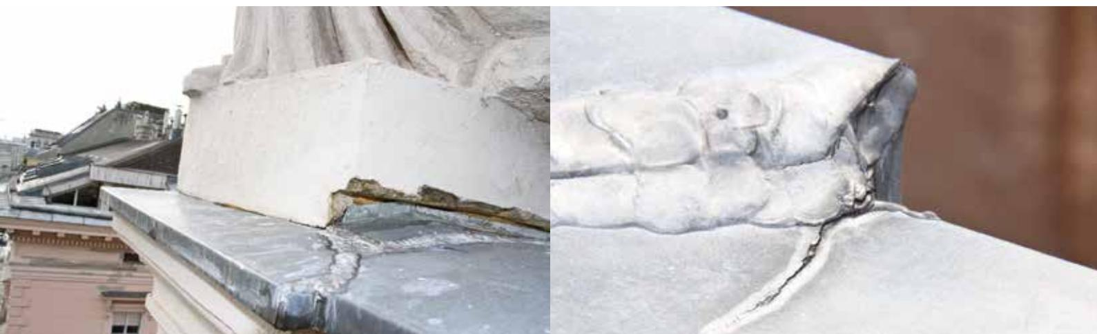
*Bild links: Der Hochzug am Figurensockel am vorderen Endpunkt zu kurz mit einem völlig offenen Loch.*
