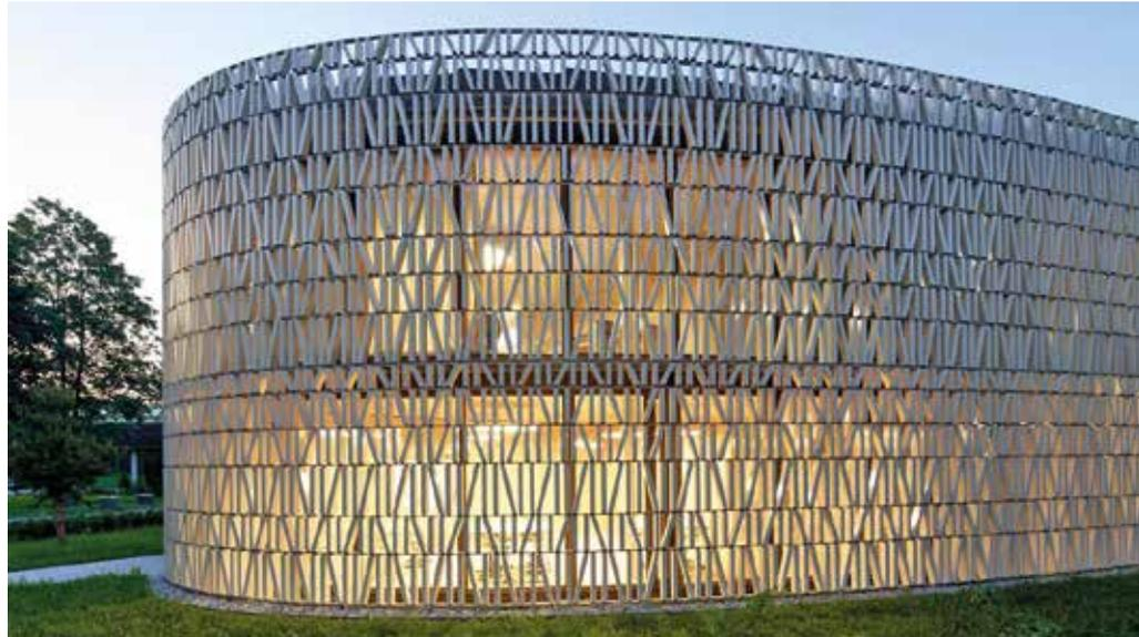
Die verwendeten Keramikbaguettes sorgen für Lichtspiele im Gebäudeinnern und verleihen dem Baukörper außen die auffällige Erscheinungsform der abstrakten Bücherfassade. Die Keramik-Elemente wurden mit speziellen Tragprofilen auf einer der gekrümmten Fassade folgenden Stahlunterkonstruktion aus vorgefertigten Leiterträgern befestigt. | Fotos: © Stefan Müller-Naumann (4)
