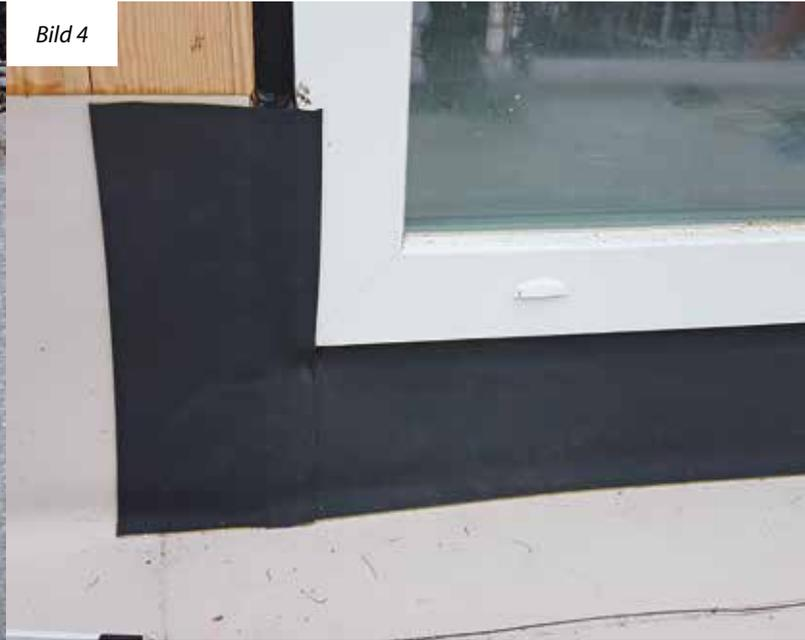
der Abdichter ans Werk. Erst danach kann der Fensterbau den Baufugenanschluss komplettieren, die Fassade kommt dazwischen und erst dann können am Fenster die Führungsschienen montiert werden.
