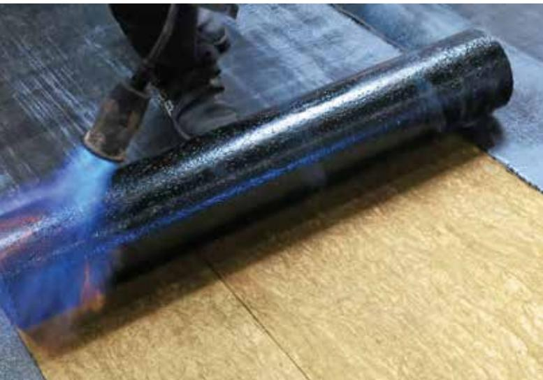
*Ab sofort lieferbar ist die neue „Bitrock“, eine Dämmplatte aus nichtbrennbarer Steinwolle im Dickenbereich von 60 bis 140 mm mit einer innovativen, planeben geschliffenen Oberfläche. Diese sichert einen optimalen Haftverbund zwischen der Dämmung und direkt aufgeschweißten Bitumenabdichtungen.*
