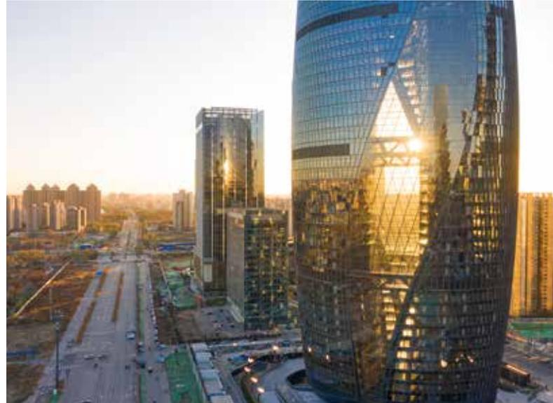
Die Glasfassade besteht aus einer Reihe von hintereinander geschalteten Glasscheiben, die zur Unterstützung der Belüftung abgekantet sind. Ziel ist es, dadurch bei den unterschiedlichen Wetterbedingungen in Peking für ein stets angenehmes Raumklima zu sorgen.
