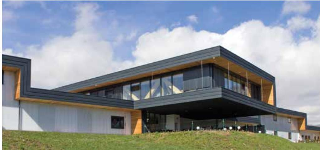
*Das spezielle Baukonzept mit metallischem Rahmen über alle Baukonturen. Das zentrale Gebäude in der Mitte der Baulandschaft krägt über das Ganze hinaus.*
