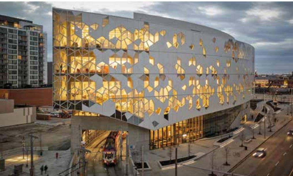
Die dynamische, dreifach verglaste Fassade weist ein modulares, sechseckiges, vielfach variiertes Muster auf. Von diesem Muster wird das gesamte Gebäudevolumen umschlossen, sodass alle Seiten als „Vorderseite“ des Gebäudes gelesen werden können. Das grafische Vokabular der Fassade setzt sich im Inneren fort und prägt die Identität der Bibliothek.
