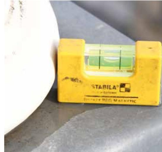
*Säulensockel mit trichterförmigem Gefälle nach innen und Wasserableitung unter die Verblechung.*
