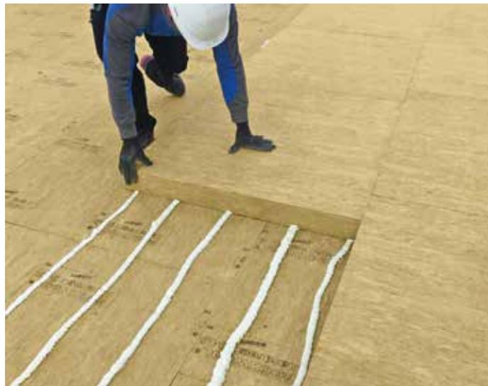
*Als besonders wirtschaftlich und sicher erweist sich die Arbeit mit der neuen „Bitrock“ Dämmplatte von ROCKWOOL. Im Windsogversuch wurde dank des optimalen Haftverbundes der Bitumenabdichtung mit der „Bitrock“ eine sehr hohe Beständigkeit der Konstruktion gegenüber Windlasten nachgewiesen.*
