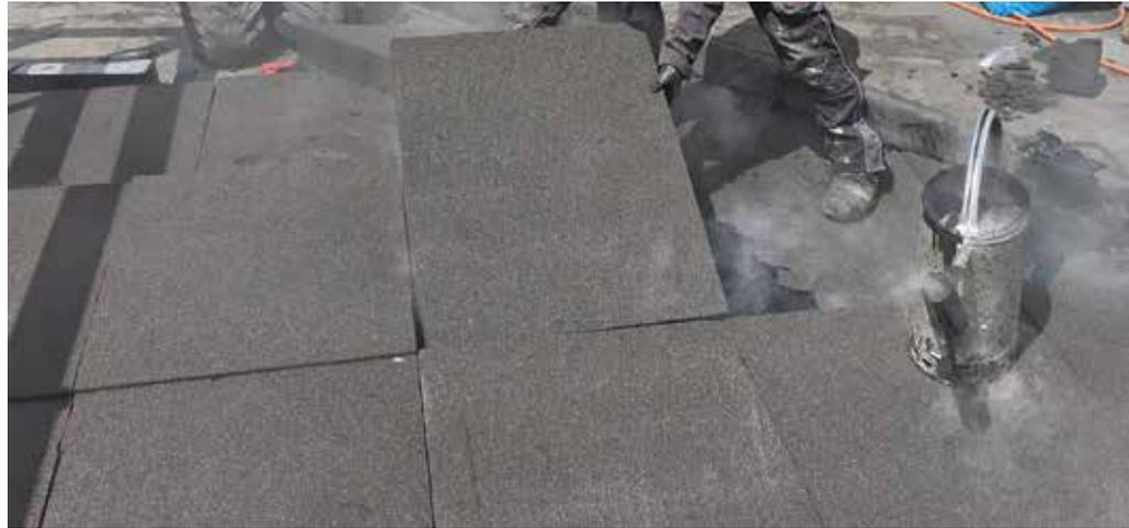
*Vollflächig und vollfugig mit dem Untergrund verklebt, bieten Schaumglas-Dämmstoffe eine baupraktisch unterlaufsichere Konstruktion. Die in Heiß- oder Kaltbitumen verlegten Dämmplatten können problemlos handwerklich angepasst werden: schneiden, fassen, hobeln - für jedes Detail stellt sich das Verarbeiten sehr einfach dar.*
