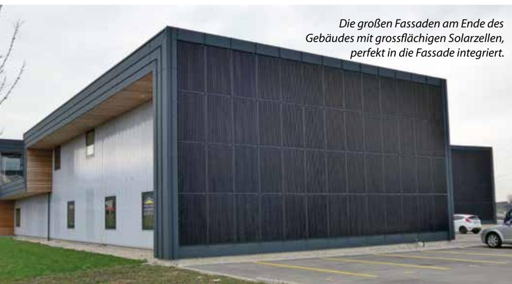
Die großen Fassaden am Ende des Gebäudes mit grossflächigen Solarzellen, perfekt in die Fassade integriert.
