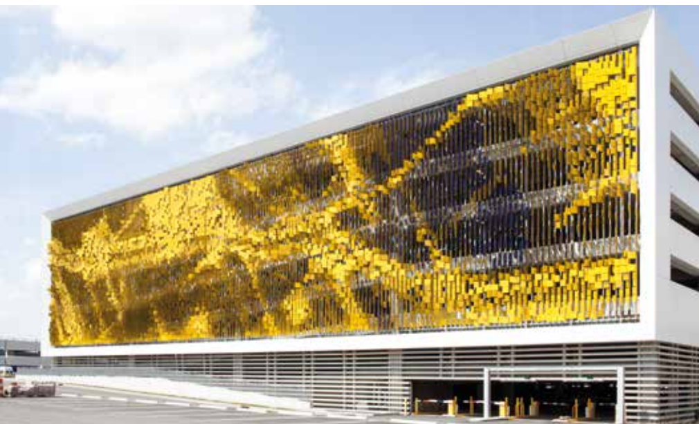
Für die Erstellung der Fassade wurden rund 6.500 geknickte Metallplatten in 18 verschiedenen Größen und Winkeln verwendet. | Fotos: © Serge Hoeltschi (2)
