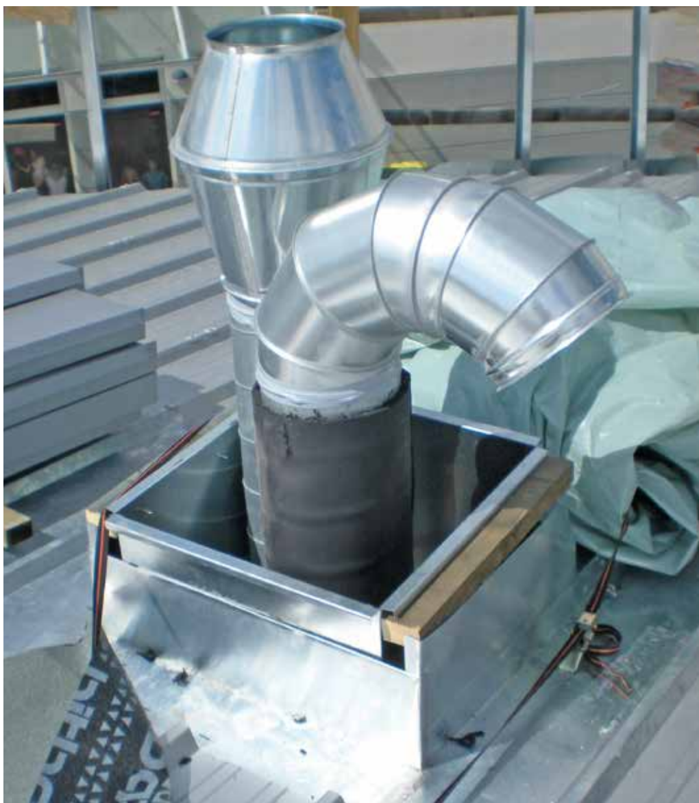
Bild 2: Nun wurden die Lüftungsleitungen montiert. Eine raumseitig luftdichte Anbindung wird zur Herausforderung.
