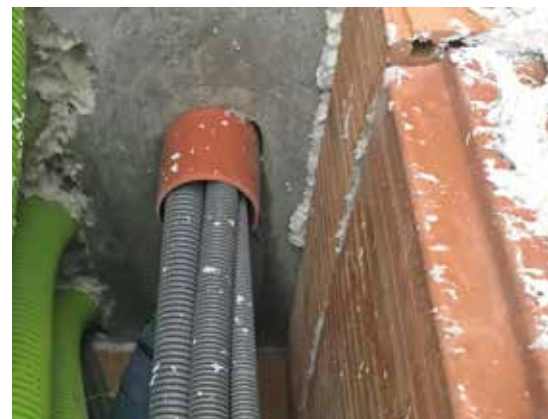
Bild 3: Bündel von Elektroschläuchen, ein häufiges Problem.
