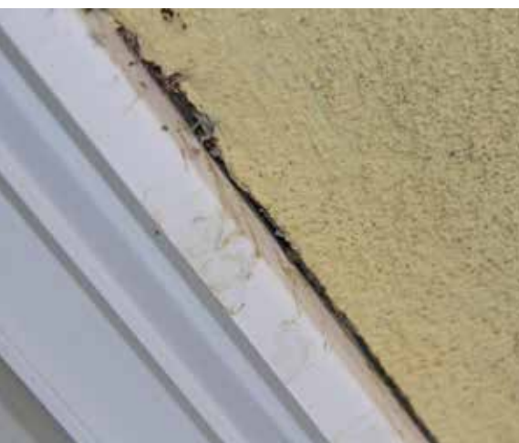
Bild 1: Wasseraustrittsstelle an der Fuge zwischen WDVS und dem Fensterstock. | Bild 2: Massiver Materialbruch in der Traufenverblechung neben der Löt naht. | Bild 3: Stützeinfassung der Terrassengeländersteher aus Blech hergestellt, darüber eine Trichterhülse.
