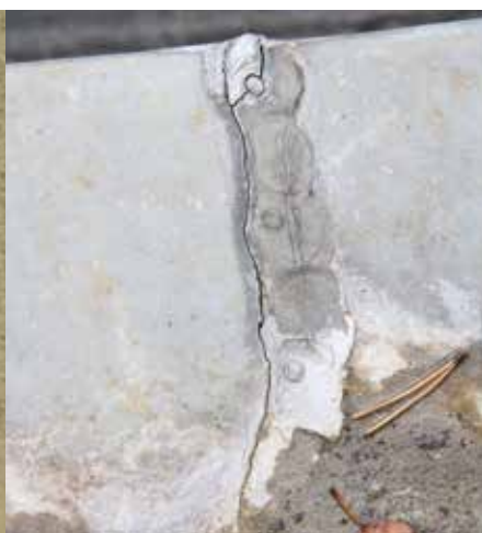
Bild 1: Wasseraustrittsstelle an der Fuge zwischen WDVS und dem Fensterstock. | Bild 2: Massiver Materialbruch in der Traufenverblechung neben der Löt naht. | Bild 3: Stützeinfassung der Terrassengeländersteher aus Blech hergestellt, darüber eine Trichterhülse.
