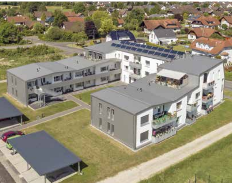
Im hessischen Reinhardshagen ist die Wohnanlage 50plus entstanden. Für die Dacheindeckung und Fassadengestaltung kam das System RIB-ROOF 465 von Zambelli zum Einsatz.
