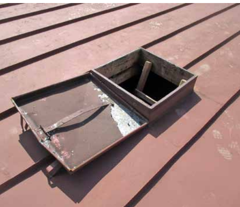
Bild 1: Mit Blechanstrichen kann man die Lebensdauer von Blechen über viele Jahre verlängern. Mit Blechanstrichen sind auch die oft gewünschten Farbkonzepte leicht umsetzbar. | Bild 2: Die Bleche selbst müssen vom Spengler regelmäßig gewartet und instandgehalten werden. Ansonsten sind solche „Katastrophen“ nicht zu verhindern. | Fotos: © G. Braitner (4)
