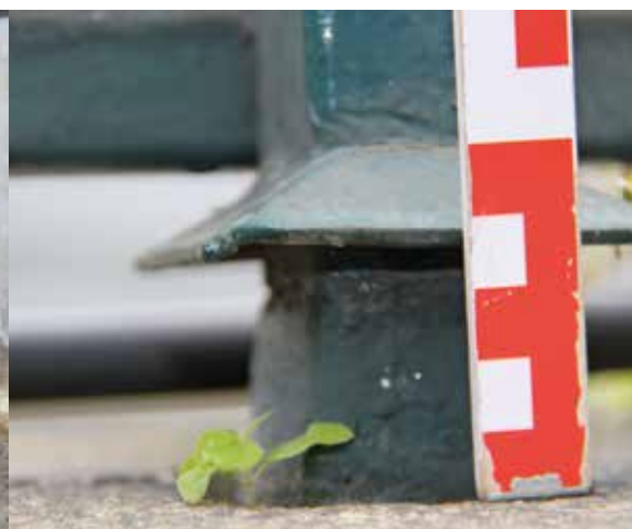
Bild 1: Wasseraustrittsstelle an der Fuge zwischen WDVS und dem Fensterstock. | Bild 2: Massiver Materialbruch in der Traufenverblechung neben der Löt naht. | Bild 3: Stützeinfassung der Terrassengeländersteher aus Blech hergestellt, darüber eine Trichterhülse.
