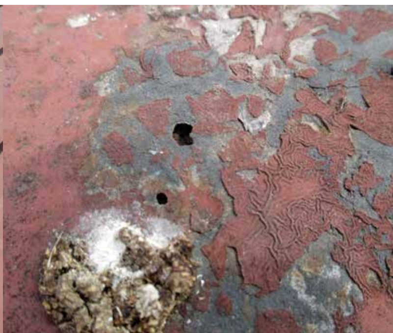
Bild 1: Mit Blechanstrichen kann man die Lebensdauer von Blechen über viele Jahre verlängern. Mit Blechanstrichen sind auch die oft gewünschten Farbkonzepte leicht umsetzbar. | Bild 2: Die Bleche selbst müssen vom Spengler regelmäßig gewartet und instandgehalten werden. Ansonsten sind solche „Katastrophen“ nicht zu verhindern. | Fotos: © G. Braitner (4)
