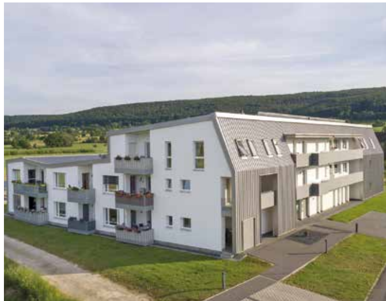
Dank des Zambelli-Metallsystems verschmelzen Dach und Fassade zu einer optischen Einheit. Highlight ist ein Gefälle-Knick in der Fassade. | Fotos: © Constantin Meyer, Köln (3)
