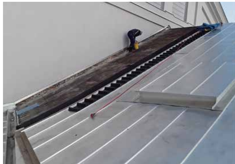
Bild oben: Sanierungsarbeiten am Kegeldach mit konischen Scharen aus Uginox Patina K41. | Bild unten: Mauerabdeckung und Dachrandausbildung. | Fotos: © Harald Mössler (2)
