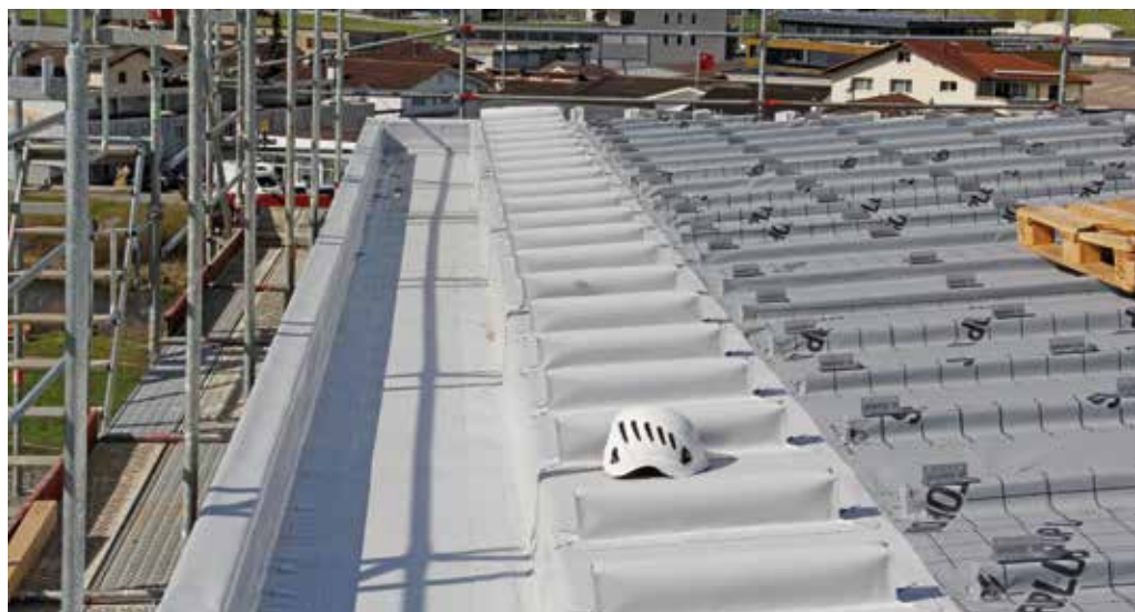
Konsequent verlegtes, dichtes Unterdach für ausserordentliche Beanspruchung im Traufbereich, mit einer UV-stabilen und rückstausicheren Lage abgedeckt.
