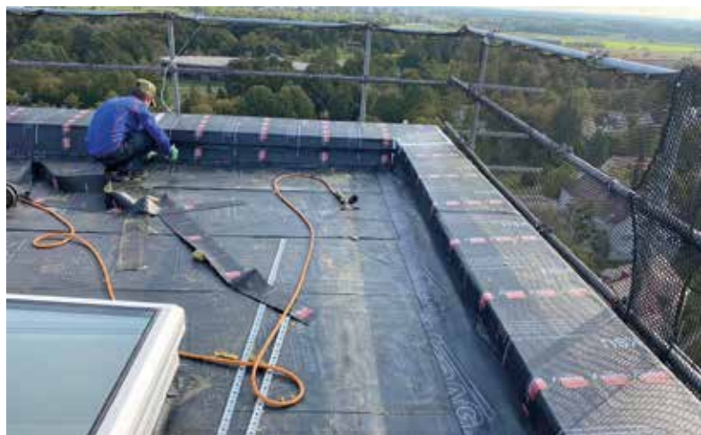
Das Seitenschutz-System von Sifatec gewährt barrierefreies Arbeiten auf der gesamten Fläche bis hin zum Dachrand.
