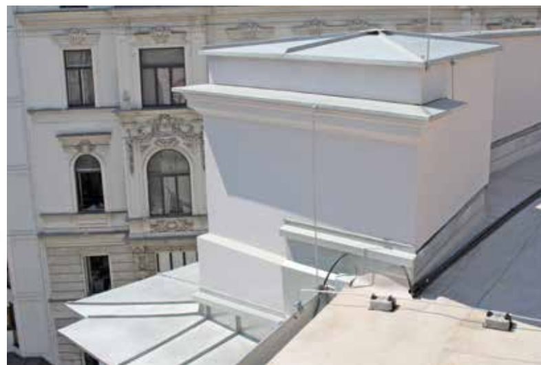
Bild oben: Sanierungsarbeiten am Kegeldach mit konischen Scharen aus Uginox Patina K41. | Bild unten: Mauerabdeckung und Dachrandausbildung. | Fotos: © Harald Mössler (2)
