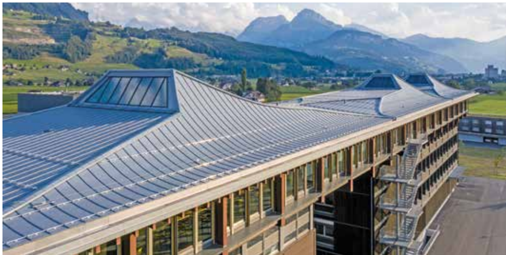
Hochexpressive und exklusive Dachform, Dachdeckung mit geschwungenen Flächen und Gräten, Doppelstehfalzdeckung mit Rheinzink prePatina.
