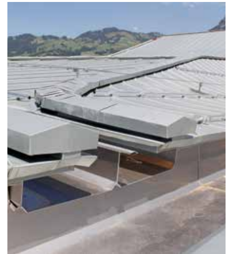
Traufanschluss, Auslauf Flächen-Querrinnen, innenliegende Rinnen und Gratauslauf, wo man auch hinsieht, perfekte Details.
