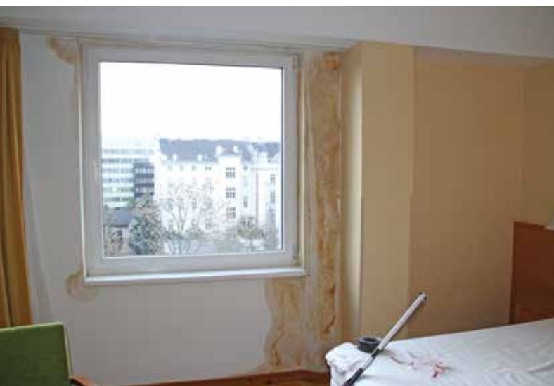
Bild 1: Der erhebliche Nässeschaden an der Wandfläche unterhalb des Steildaches.
