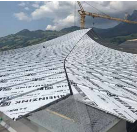
Blechbahnen auf Bauzeitabdichtung mit Wirrgelege (Strukturmatte) verlegt.
