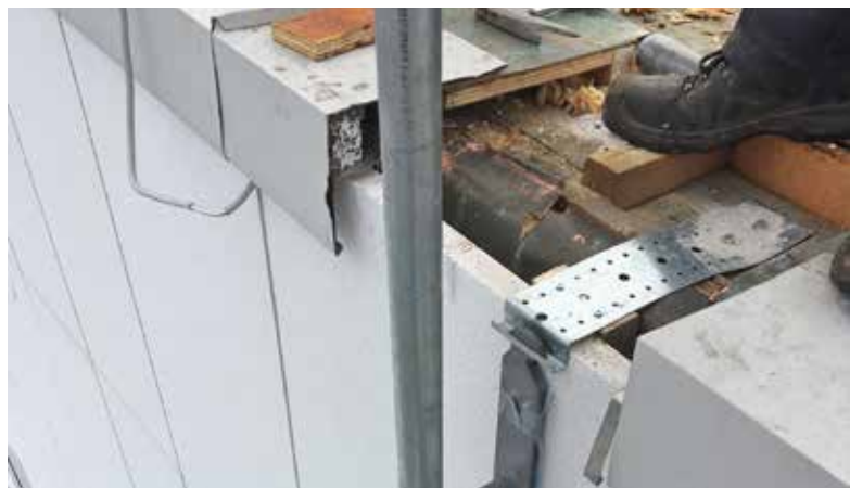
Dank des Einhängemechanismus wird der Seitenschutz über eine Schwenkbewegung sicher an der Halteplatte fixiert.
