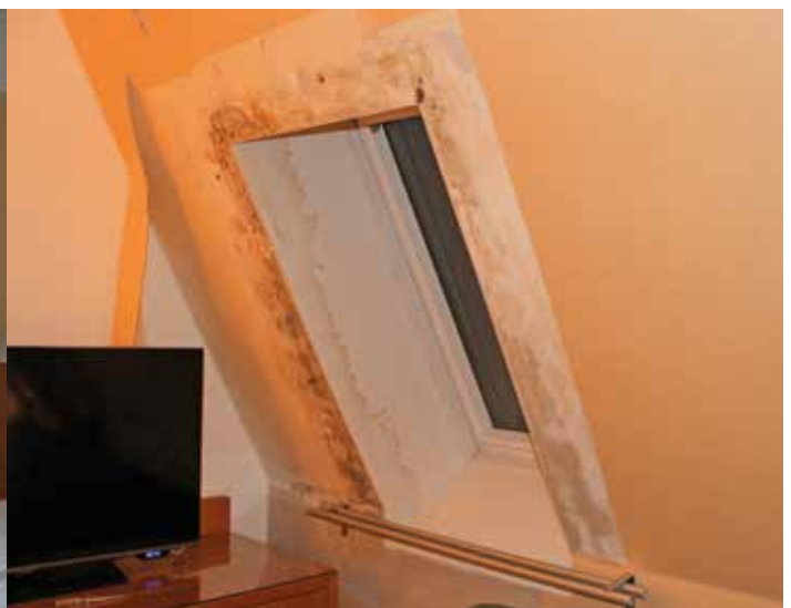
Bild 2: Der Steildachbereich über dem Nässeschaden laut Foto 1 rund um das Dachflächenfenster.
