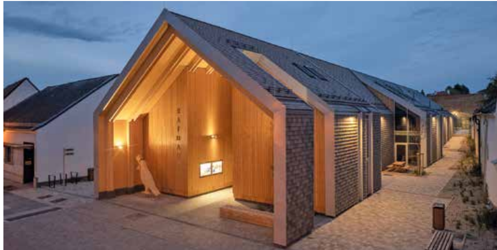
Die Anbringung aller Ziegel an der Fassade dauerte insgesamt vier Wochen, jene am Dach zwei Wochen. Fünf Mitarbeiter waren dabei im Einsatz.
