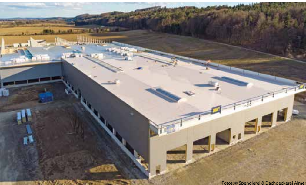
Fotos: © Spenglerei & Dachdeckerei Almer
