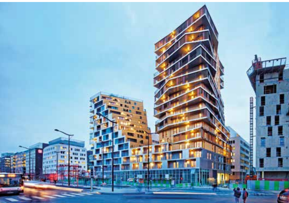
Das Gebäude ist als Stahlbetonbau mit raumhohen Fenstern unterschiedlicher Breite und wechselnder Position errichtet. Die massiven Außenwände wurden rundum mit einer Metallverkleidung aus Aluminium versehen. | Fotos: © Takuji Shimmura (4)
